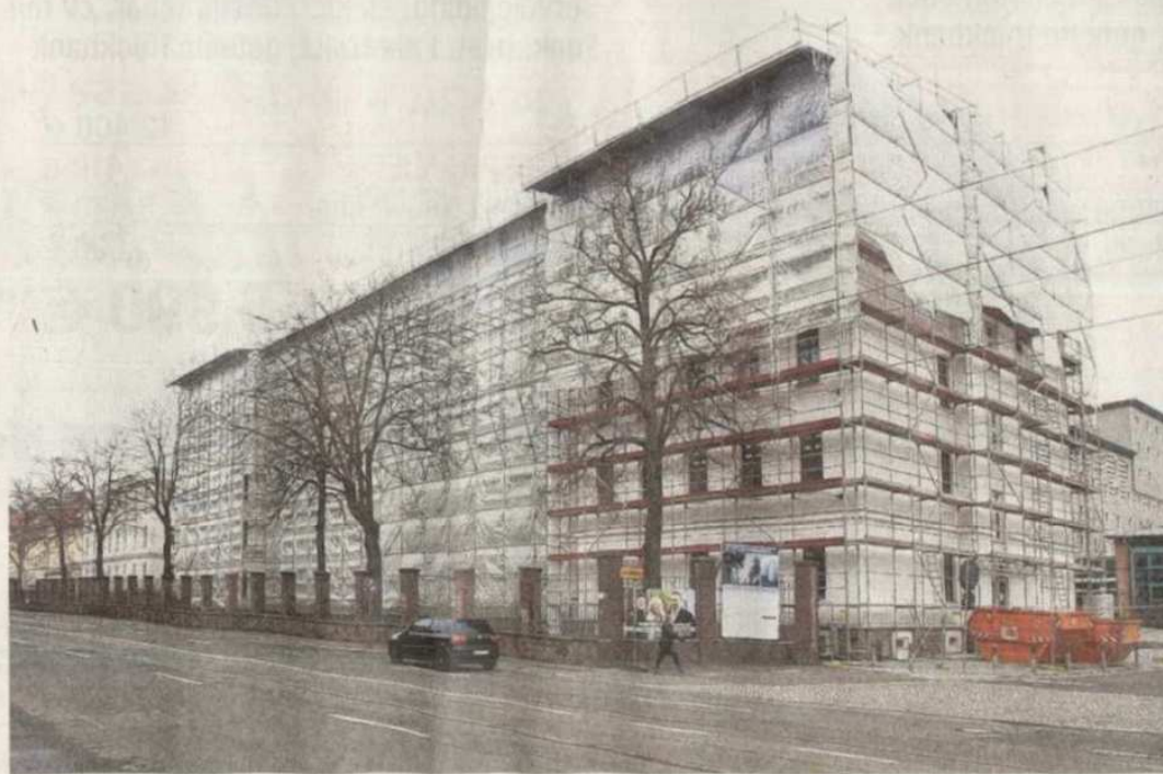
Arbeiten am Berufsförderungswerk unter Denkmalschutzaufgaben. Die historische Einzäunung will die Stadt beim Umbau der Schumannstraße aber opfern. Foto: André Kempner
